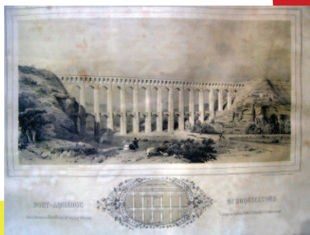
L'aqueduc de Roquefavour
